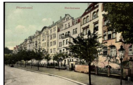
Gaststätte Rodensteiner (Bleichstr. 90) in der Mitte mit Balkon, vor 1914 (Urheber unbekannt)
