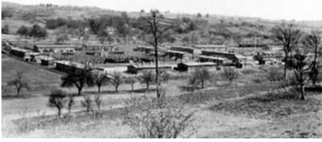
Lager Odenheim für „displaced persons“, bis zur Befreiung 1945 RAD-Lager (Reichs-Arbeits-Dienst), ab 1944 Zwangsarbeiterlager für die verlagerte Kriegsindustrie (Rheinmetall-Borsig) (Foto: Heimatkundlicher Arbeitskreis Odenheim)
