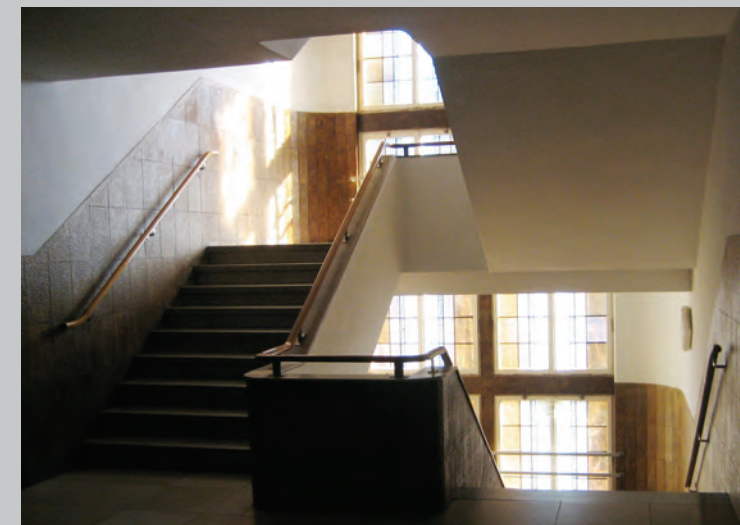
Blick in das erhaltene Treppenhaus 2013
